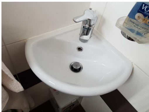
Wc v přízemí (místnost B.05)
