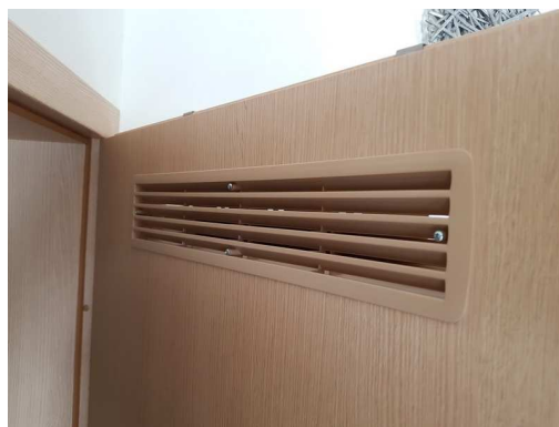
Vnitřní dveře v přízemí – provětrání
