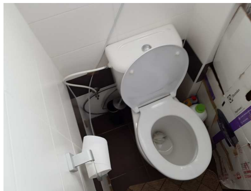
Wc v přízemí (místnost B.05)
