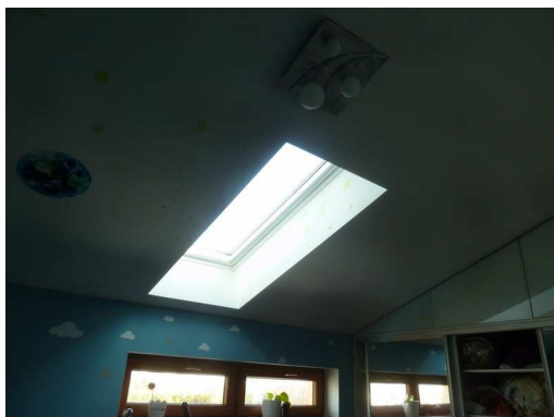
Střešní okno v místnosti B.1.1.
