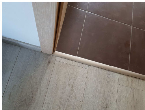
Přechod podlahy mezi chodbou a pokojem
